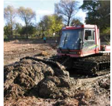
Schwere Technik war nötig zur Entschlammung eines Solls bei Zixdorf
